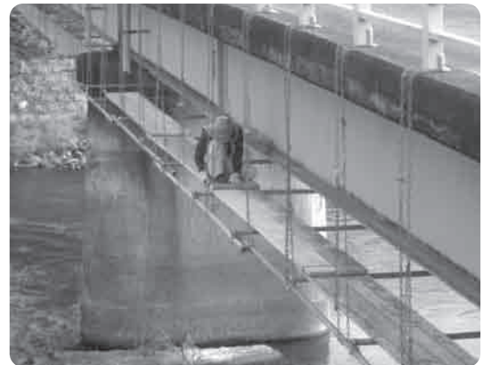
橋の維持補修工事
